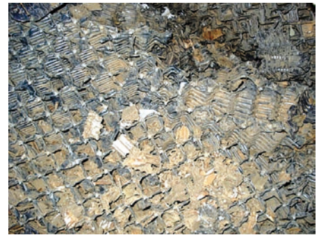
Verschmutzte Kühlturmeinbauten
