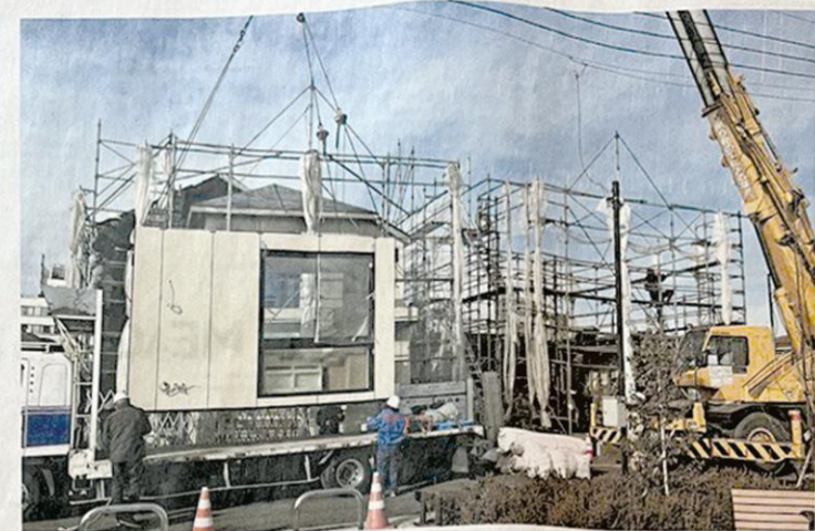
Bauen in Japan: Durch die Vorfertigung kommt das Haus schon in einzelnen Bestandteilen auf der Baustelle an. Foto: Tim Kanning
